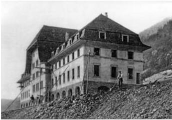
17. La nouvelle gare de Vallorbe, mise en service en 1913, a presque une allure de forteresse perchée au sommet de son talus. On a dû construire deux étages de caves en dessous du niveau de l'entrée principale, afin de consolider le terrain, constitué de remblais sortis du tunnel du Mont d'Or. Essaie d'imaginer qui étaient les gens qui pouvaient habiter un si gros bâtiment, sur les quatre niveaux habitables.
